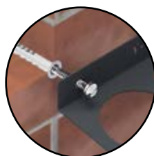
MOCOWANIE DO ŚCIANY
