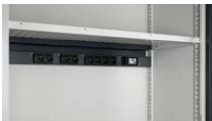
Anbringung des Energiekanals im unteren Bereich des Lochbodens/der Lochplatte
