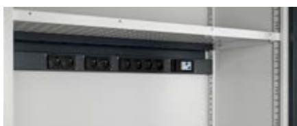
Anbringung des Energiekanals im unteren Bereich des Lochbodens/der Lochplatte
