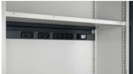
Anbringung des Energiekanals im unteren Bereich des Lochbodens/der Lochplatte
